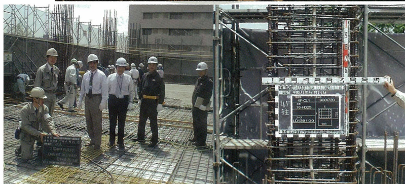
●躯体鉄筋工事 今世間を騒がせている建物構造の安全性については、構造計算書の精査をはじめ、施工の各段階において設計者、施工者、施主の三者による配筋検査を必ず実施しました。したがって、建物の耐震性能にはまったく問題ないことを確認しております。
